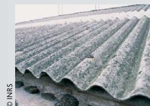
Amiante ciment (plaques toitures, canalisations, bardages...)
